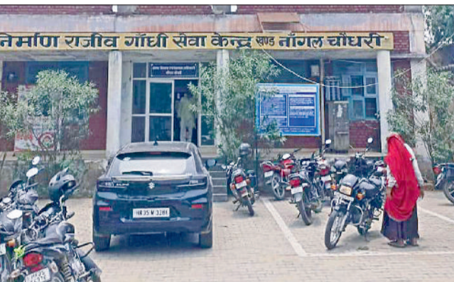
नांगल चौधरी। पंचायत समिति कार्यालय की छत पर रोका गया निर्माण कार्य। फोटो: हरिभूमि
